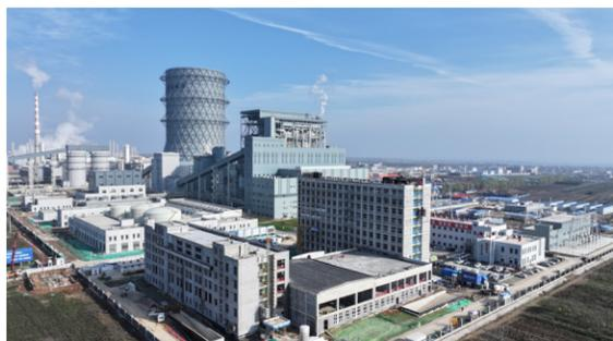
11月27日，研制的世界首台参数最高、单机容量最大陕西彬长660兆瓦高效超超临界循环流化床（CFB）发电项目1号机组顺利通过168小时满负荷试运行，正式投入商业运行
